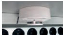
Rauchmelder zur Überwachung auftretender Rauchentwicklung im Schrank
