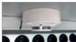
Rauchmelder zur Überwachung auftretender Rauchentwicklung im Schrank
