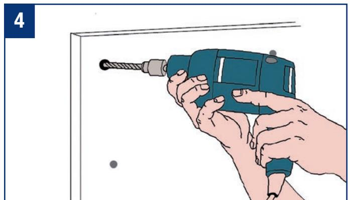
Nehmen Sie die Montageplatte weg und bohren Sie die Löcher an den Markierungen.
